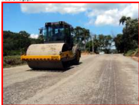
Trecho da Rodovia sendo executado
