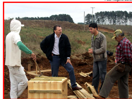
Hamm e prefeito acompanham obras
