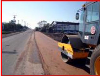
Uma das melhorias foi o alargamento da via
