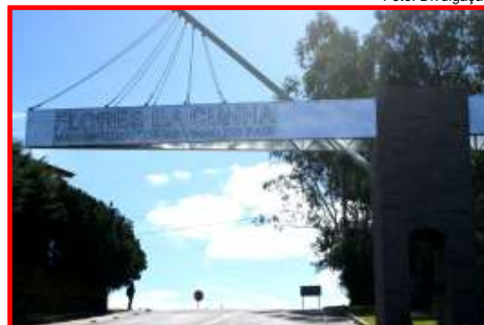
Estrutura dá acesso à zona Norte
