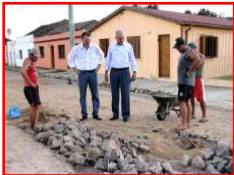
Hamm e prefeito Chiquinho vistoriando as obras de calçamento
