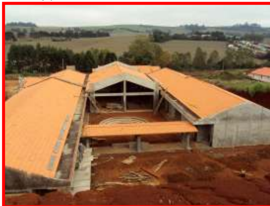
Obras terminam em setembro
